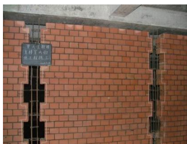
图3.5.2-1 烧结普通砖墙
