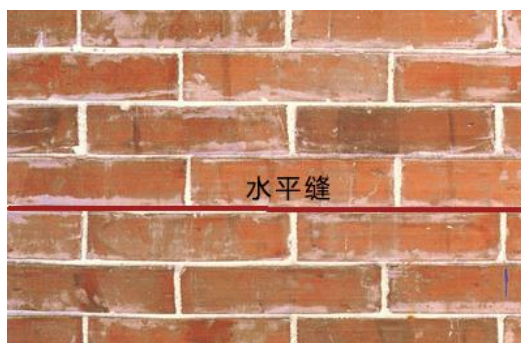
图 5.2.4 水平灰缝
